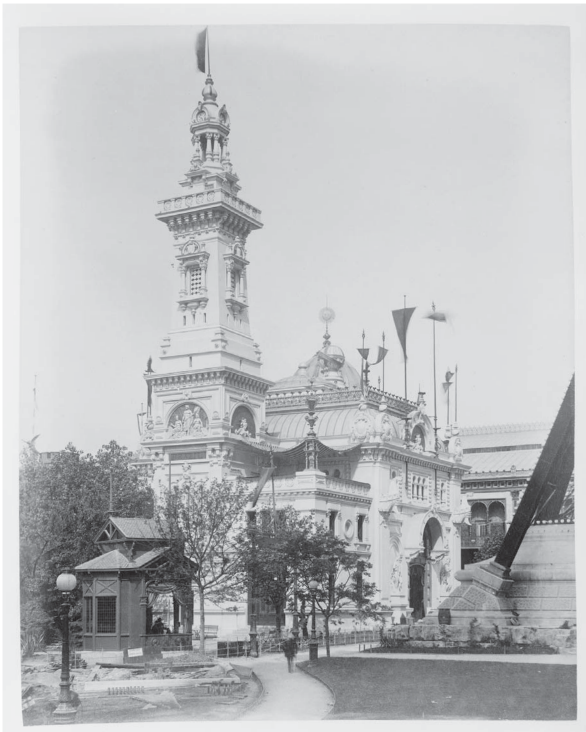
Fig. 2: Detalhes da fachada do prédio. 3
