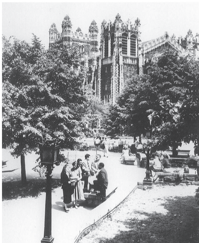
Fig. 3. Shepard Hall, campus del City College, Nueva York. Década de 1950. Reproducido en Sydney van Nort. 2007. The City College of New York . Charleston: Arcadia, 4.
