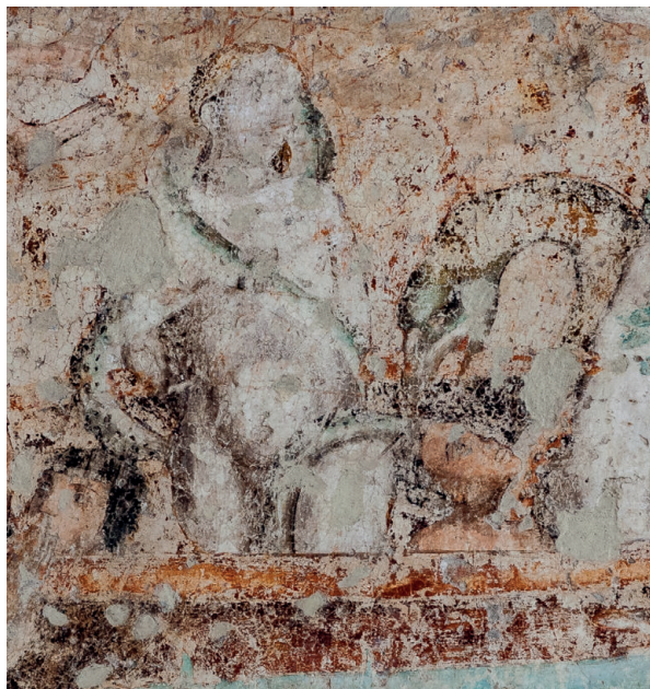
Figura 9. Detalle del muro de la epístola, capilla abierta de Actopan, Estado de Hidalgo, México (foto: José Luis Pérez Flores, 31 de diciembre de 2006).
