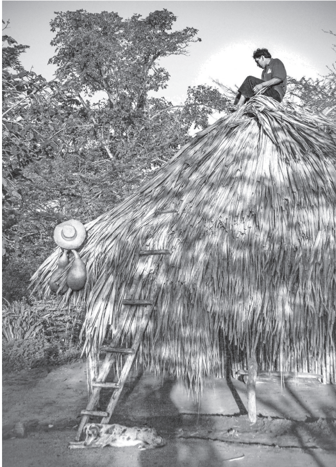
Figura 14. Construcción de la casa jaataka' . Ette Butteriya 2010 (fotografía: J. C. Niño Vargas).
