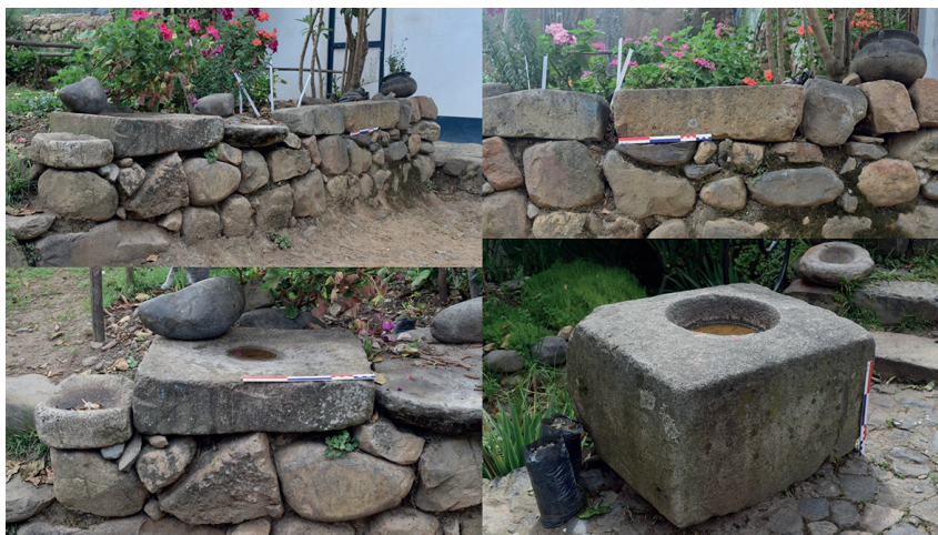
Figura 7. Muro rústico moderno, ubicado en patio trasero de una casona (contigua al lado sur de la Plaza de Armas) de Huamachuco. Nótese las piedras canteadas y pulidas. Las imágenes inferiores muestran que las piedras son reutilizadas como mortero o batán (fotos: Lorenzo Risco Patiño, 2020).
