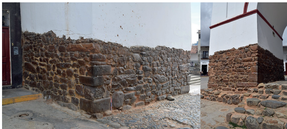
Figura 5. Las esquinas interiores del Campanario de Huamachuco muestran piedras pulidas y canteadas de manufactura inca. Las imágenes fueron tomadas desde ángulos opuestos de las columnas (fotos: Lorenzo Risco Patiño, 2020).
